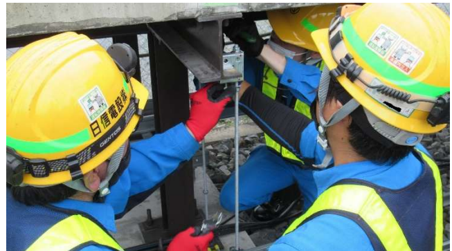
ホームドア配線用ラック取付（審査項目）
